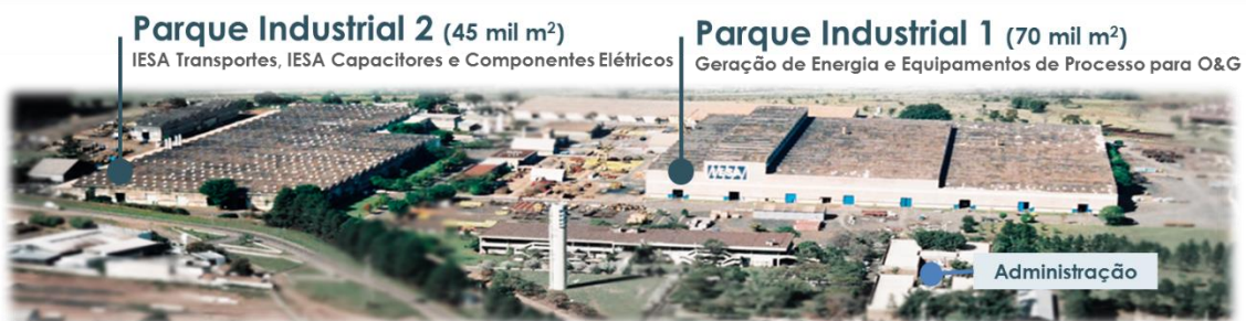
Figura 4: Parque Industrial de Araraquara
